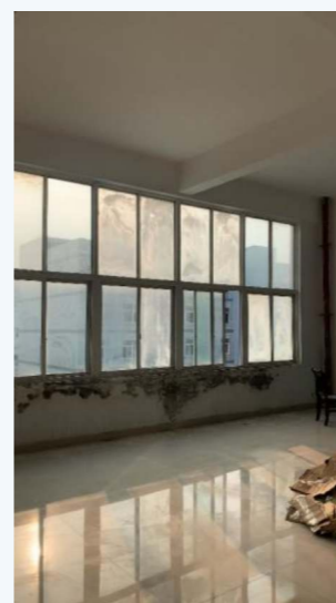
● 空港工厂改造前
