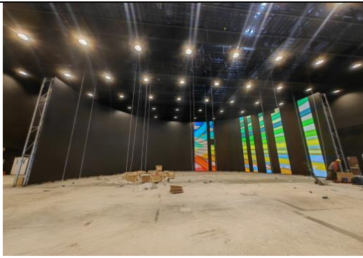
助力北京亦庄某虚拟拍摄基地搭建
