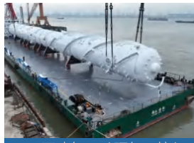
30 万吨年 EO(环氧乙烷) 装置核心静设备—洗涤塔
