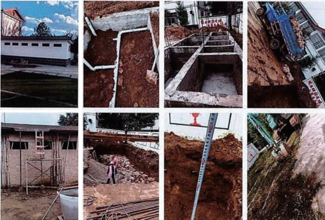
玉龍縣白沙完小浴室建設項目現場施工情景
