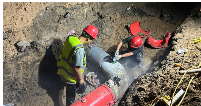
稷山供水改造现场
