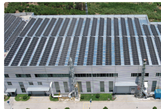
优泰科厂区铺设屋顶光伏
