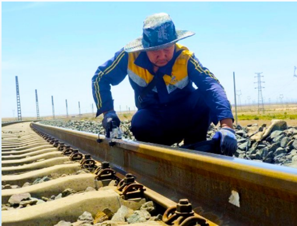
公司探伤工手持焊缝探伤仪对铁轨进行探伤作业
