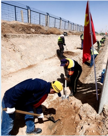
2024 年 4 月 23 日，宁东铁路工电段工务维修车间开展“防风险 除隐患 遏事故 助力防汛保运”主题党日活动，积极主动落实灾害天气安全风险隐患排查整治工作，全面保证管内设备排水畅通，共清理侧沟 800 余米，确保侧沟排水功能完善，排水能力良好，保障路基、线路稳定和列车安全平稳运行。
