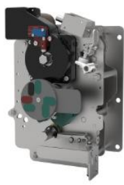
环网柜组合电器单元操作机构
