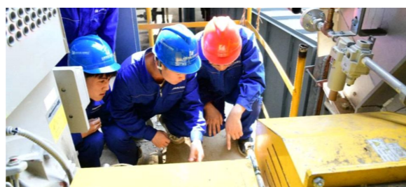
公司5#、6#焦炉备用干熄焦重点工程项目进入煤气点火烘炉阶段
