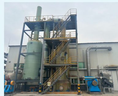
公司潍坊西厂区 烘干湿捕器升级改造
