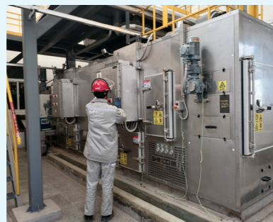
公司潍坊东厂区 新建污泥干化装置
