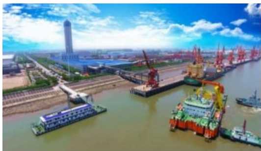
亨通国家电网舟山项目
