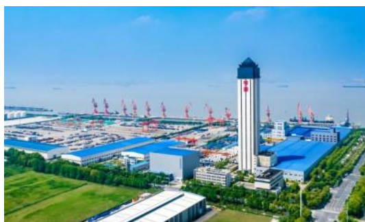
苏州常熟亨通国际海洋产业园
