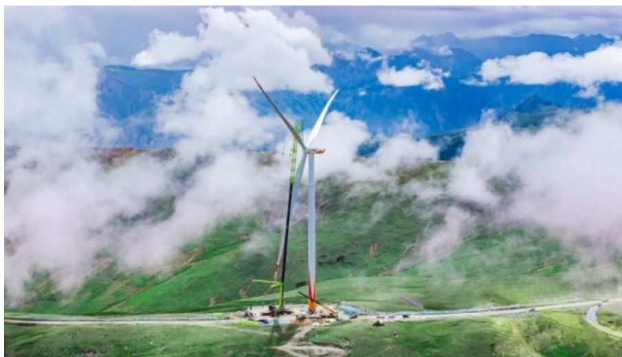
亨通方案助力全球海拔最高风电机组成功吊装
