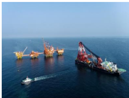
中海油渤中-垦利油田群岸电应用工程项目
