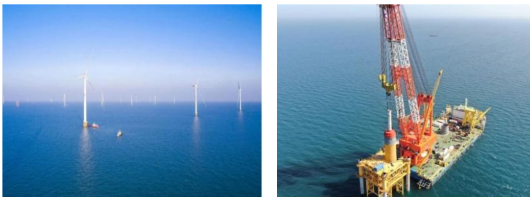
亨通华能临高海上风电项目
