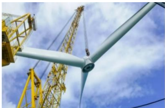
亨通浙能台州1号海上风电项目风机安装工程
