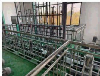
阳极氧化工艺废水处理站中水回用处理系统，中水回用率可达60%
