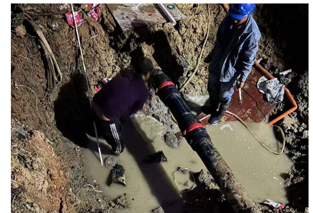
管网维修内容
