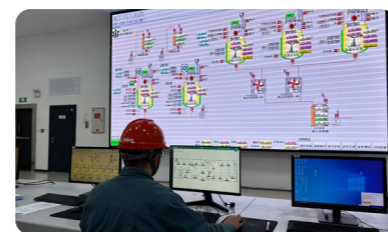
▲ 通过信息化系统远程监控现场环境及操作现场反应
