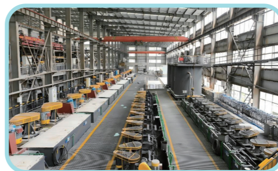
东波选矿厂生产车间
