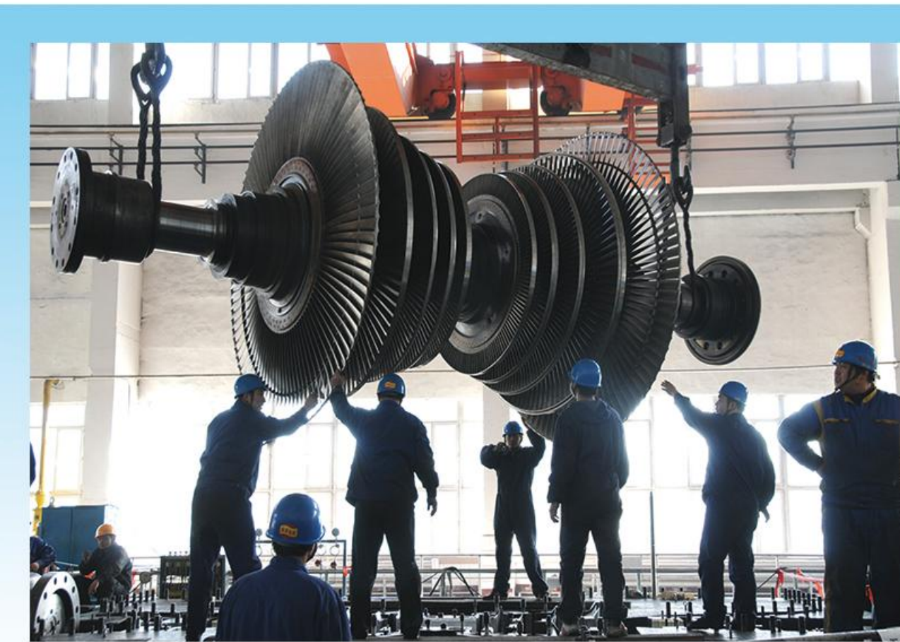
哈三电厂发电机转子吊装
