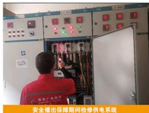
安全播出保障期间检修供电系统
