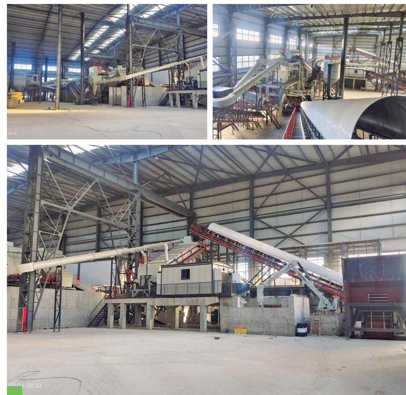
建筑废弃物再生利用整体解决方案
