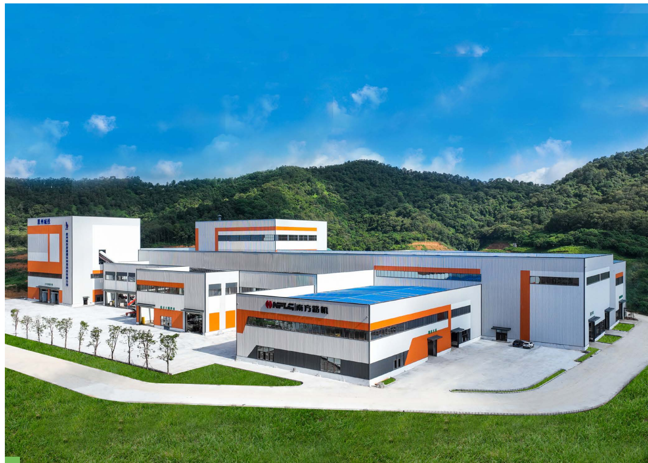
惠州城投大瑶池建废资源化综合产业园
