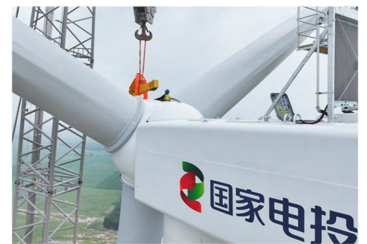
首台风机正在吊装作业
