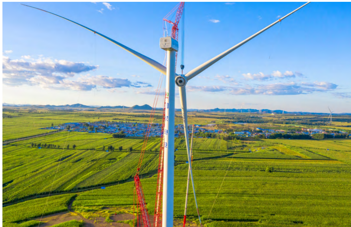
兴安盟突泉县445兆瓦风电项目建设工作正如火如荼地进行中，截至2025年4月22日，项目已完成48台风机的吊装工作
