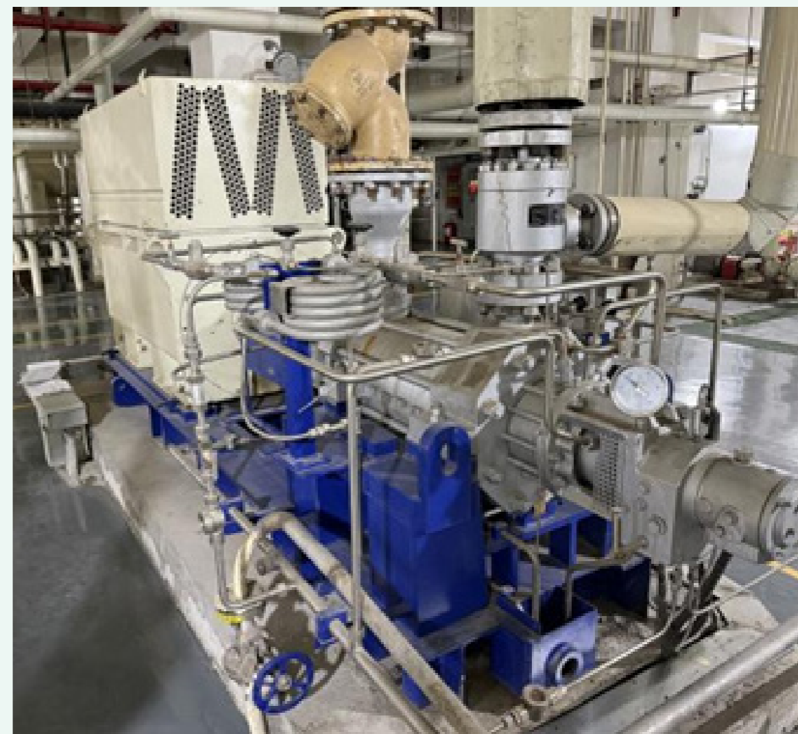
| 更换高效给水泵 |
