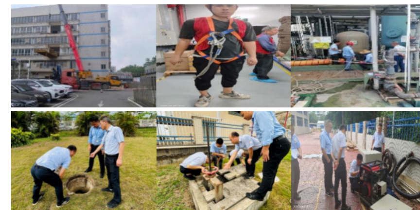
开展专项安全检查
