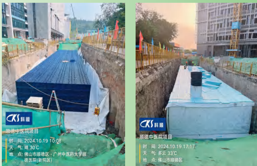
雨水回收施工现场
