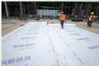
顺德中医院科顺绿洲施工现场
