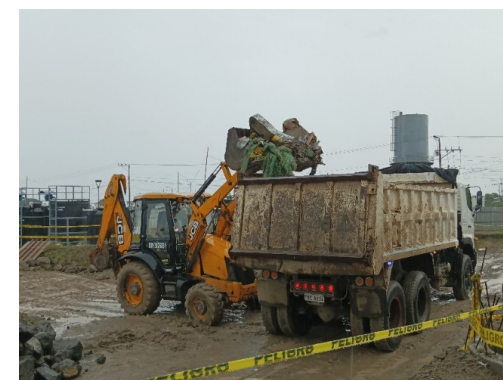
项目完工后清理建筑垃圾
