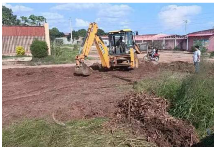
安哥拉马兰热河流疏浚项目所在的社区道路被冲出大沟，项目组及时跟当地社区沟通，派出工程车辆，修复社区道路，极大地便利了社区居民出行。
