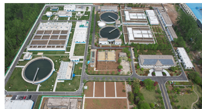
邳州市城北污水处理厂生物除臭装置
