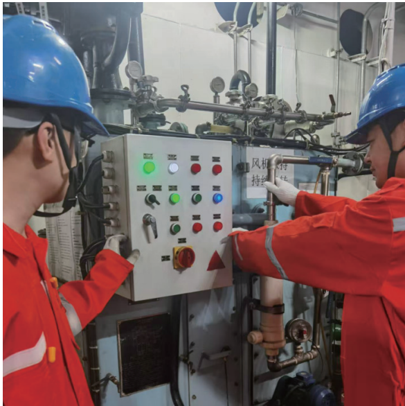
生活污水处理装置检修
