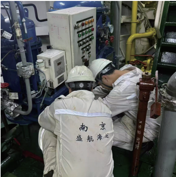
油水分离器检修
