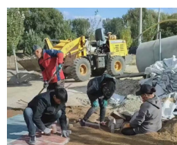
彩砖破损维修
