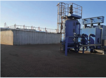
營口新港礦石碼頭汙水處理廠擴容改造
