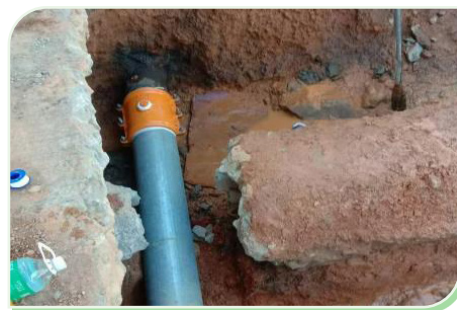
供水管維修後
