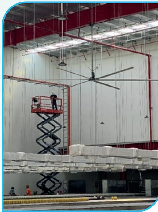
第二間工廠的生產車間亦安裝了8台蒸發式空氣冷卻器(運用冷凍水冷卻空氣)，與吊扇結合使用。
