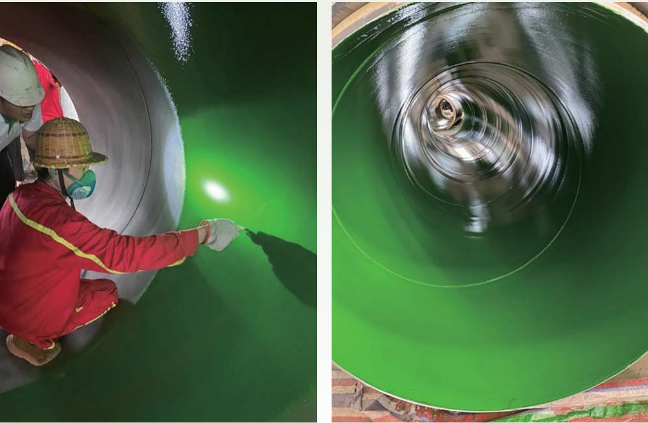
三棵树管道内减阻防腐涂料
