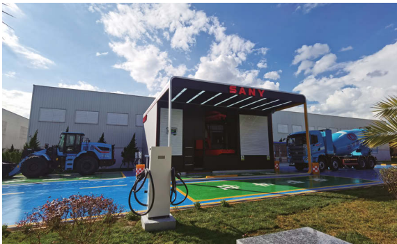
重卡充換儲綜合能源站
