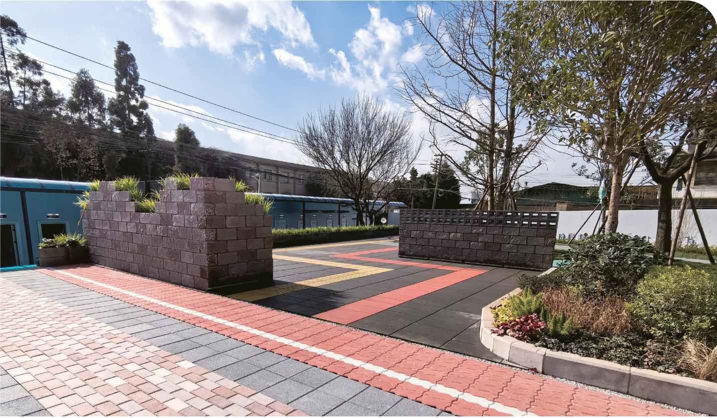
磷石膏骨料生態透水磚鋪設效果圖
