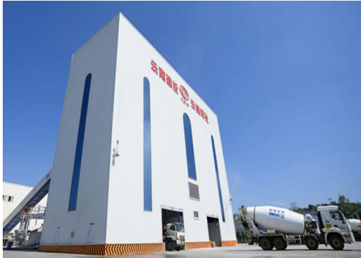
全封閉式攪拌樓
