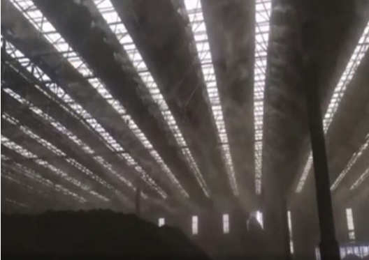
全封閉式料場+自動噴淋系統
