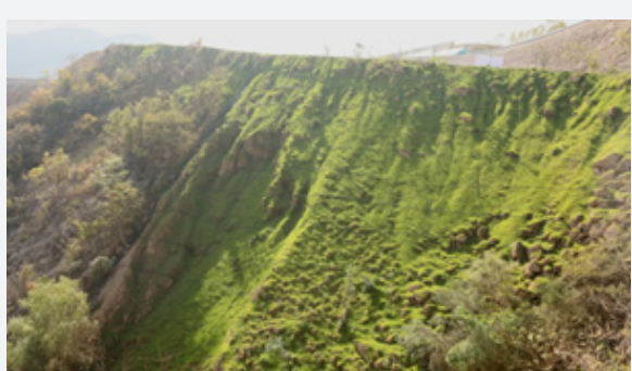
• 寨口「隅綿」結合糯米基環保噴播技術成效
