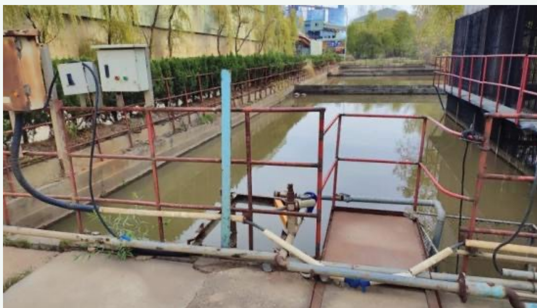
厂区内污水沉淀池
