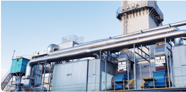
RTO 余热设施改造
