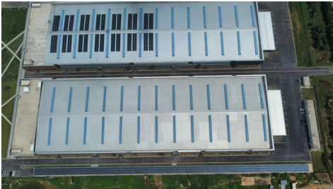
滁州产业园屋顶光伏板
