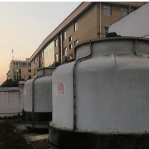
南昌华翔水循环水池
