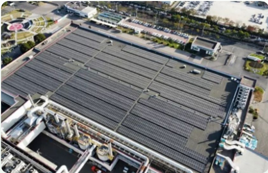
杉金光电（南京）光伏项目
