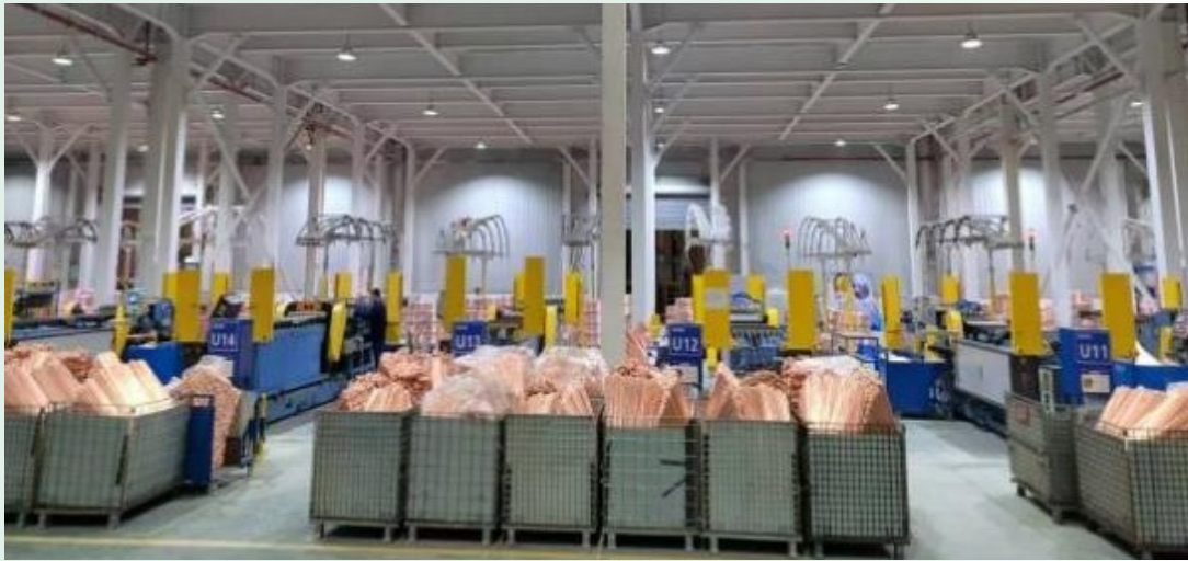
两器工厂车间照明灯更换
