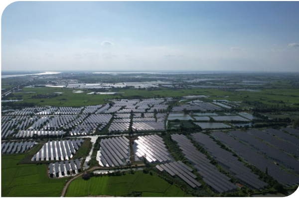
汉川公司麻河一期光伏基地
