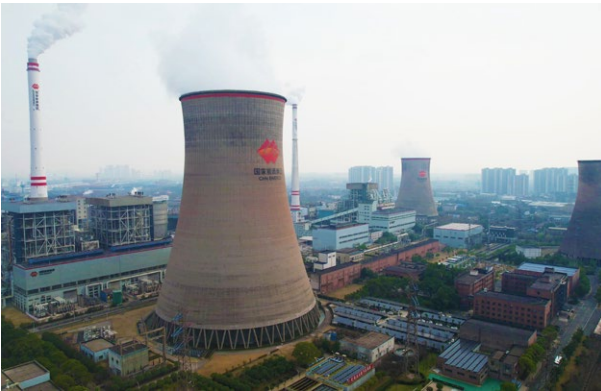
青山公司厂内分布式光伏全容量并网，有效节约厂用电，提升能源利用效率
