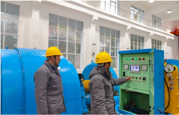
恩施公司检修维护电站机组设备
