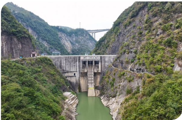
恩施公司野三河水电站
