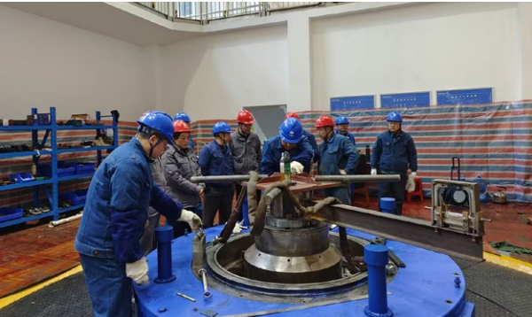
恩施公司检修分公司分别对有检修计划的电站机组设备开展全面检修维护工作
