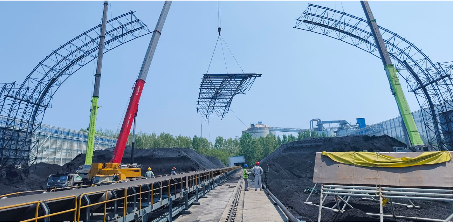
荆门公司实施 A 煤场封闭改造
