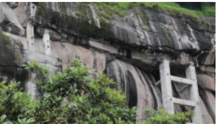
防范山体滑坡-后山加固
