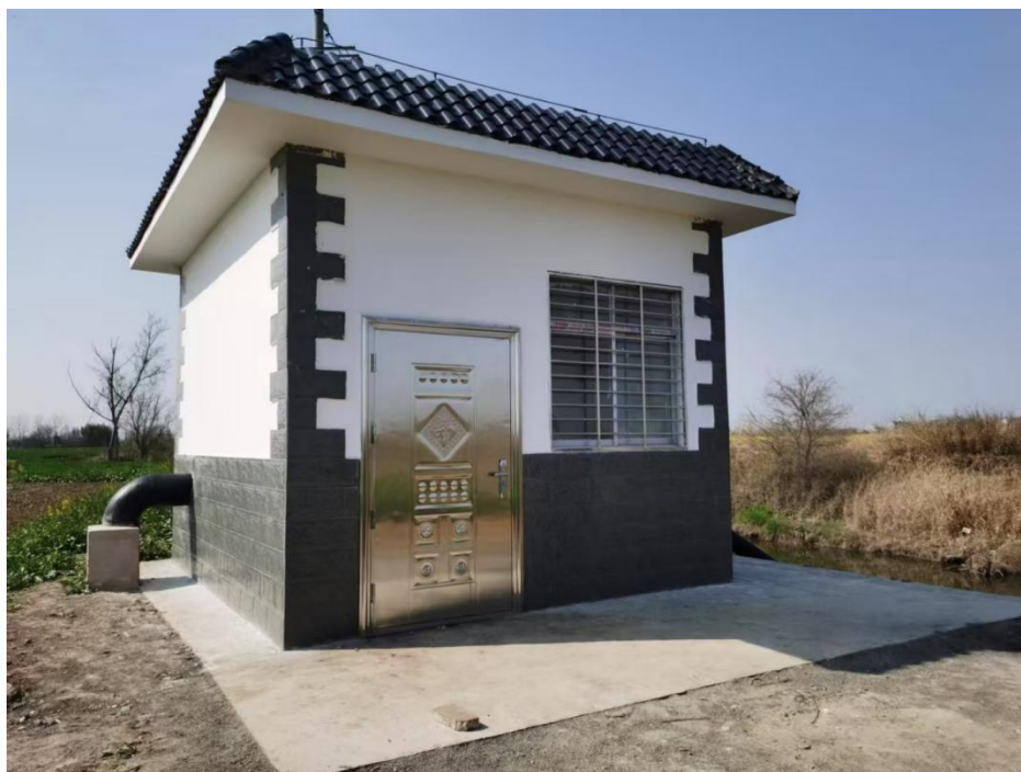
图 公司资助新建设的抗旱泵站
