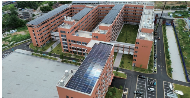
韶关浚江职业学校分布式光伏发电项目
