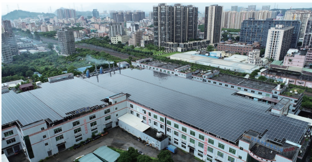
东莞凯升电子有限公司分布式光伏发电项目
