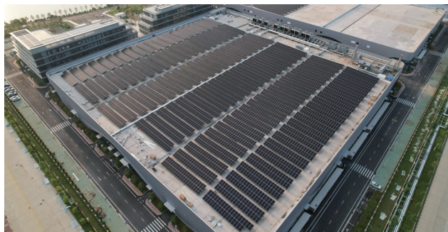
九江濂溪区仓储物流加工一体化智慧中心屋顶光伏发电EPC项目
