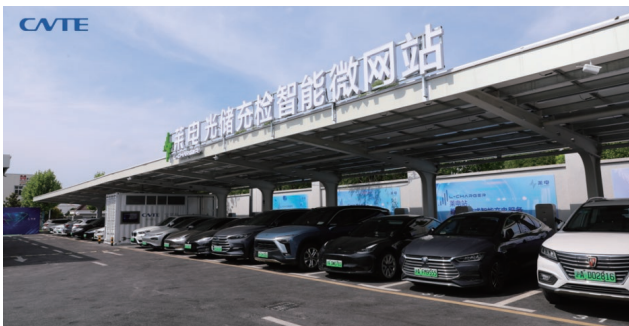
上海宝莱特光储充检一体化充电站
