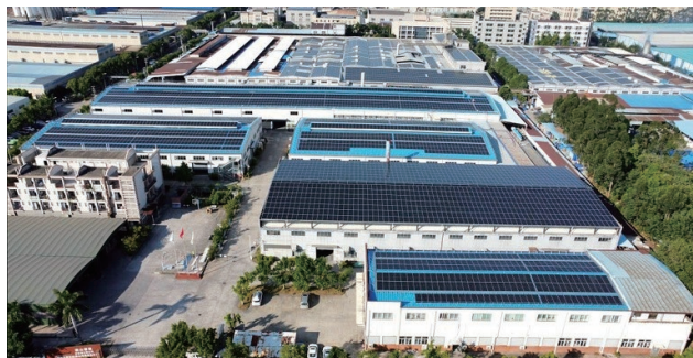
佛山市赛能新能源有限公司分布式光伏发电项目
