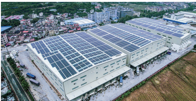
广州增城鸿昇物流工业园分布式光伏发电项目
