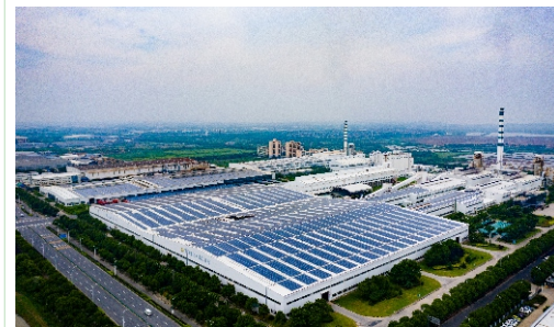
厂区光伏发电实现能源的综合利用
