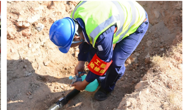
燃气泄漏应急演练
