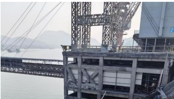
为皮带机安装挡板
