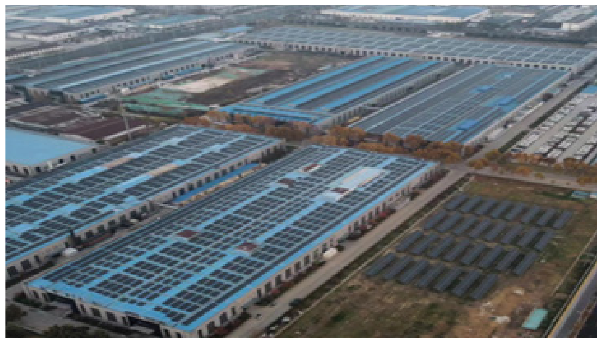
秀强厂区光伏发电屋顶
