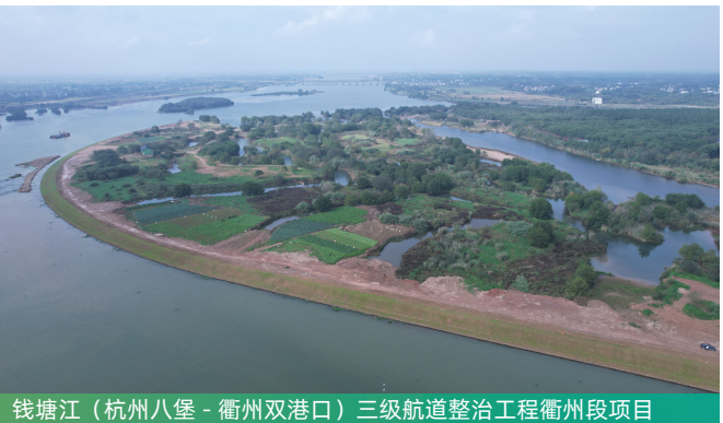
钱塘江（杭州八堡 - 衢州双港口）三级航道整治工程衢州段项目
