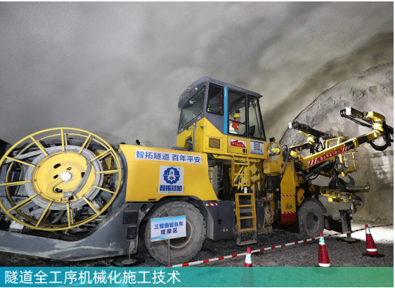
隧道全工序机械化施工技术
