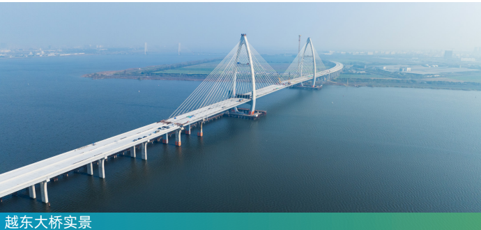
越东大桥实景
