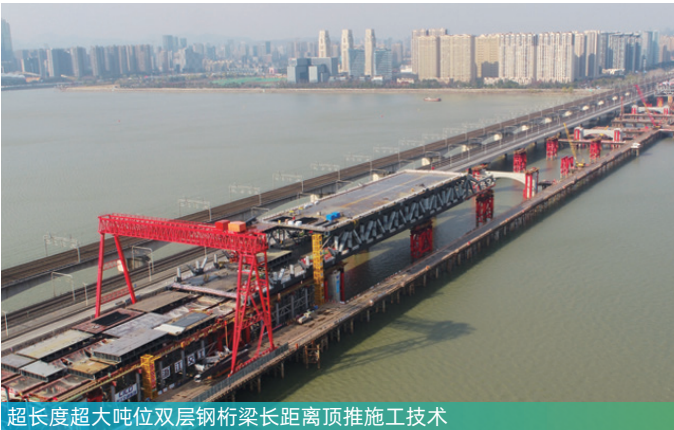
超长度超大吨位双层钢桁梁长距离顶推施工技术
