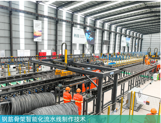
钢筋骨架智能化流水线制作技术
