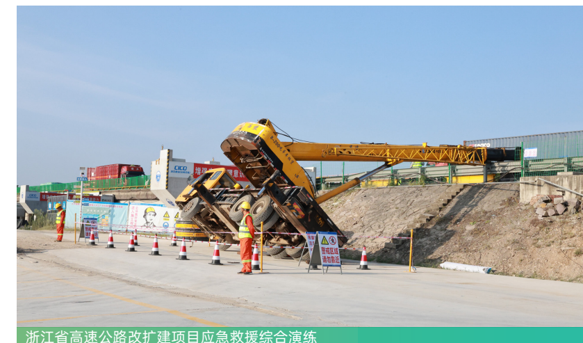
浙江省高速公路改扩建项目应急救援综合演练
