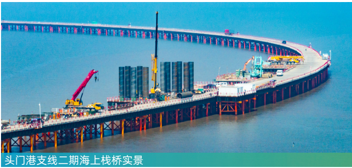
头门港支线二期海上栈桥实景
