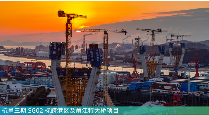
杭甬三期 SG02 标跨港区及甬江特大桥项目
