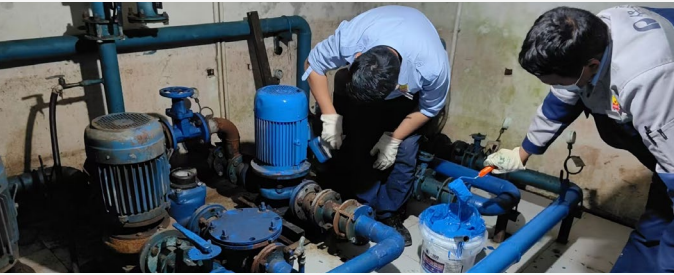
安裝水資源回用設施
