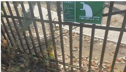
厂区污水接口
