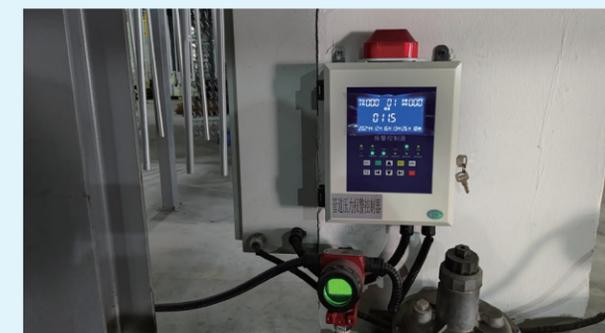
可燃气体压力监测报警装置
