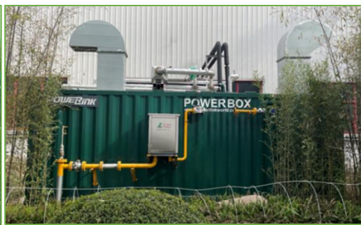
图注 新建三联供机器项目
