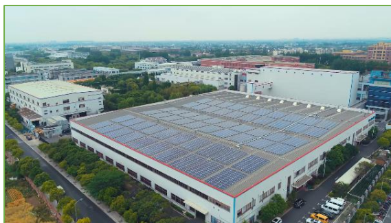
图注 屋顶自建屋顶光伏电站项目
