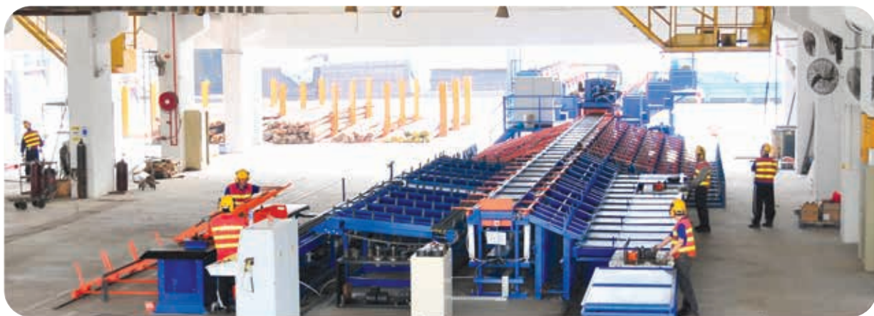
香港大埔之鋼筋自動化加工工場
