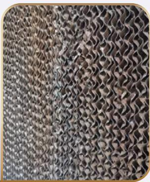
溫暖的空氣穿過水飽和的墊子，導致水蒸發並冷卻中央洗衣房內的空氣。
